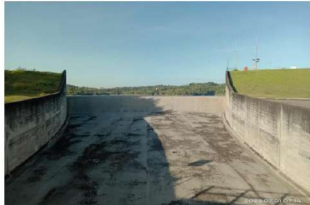
Spillway Bendungan Kedungombo
