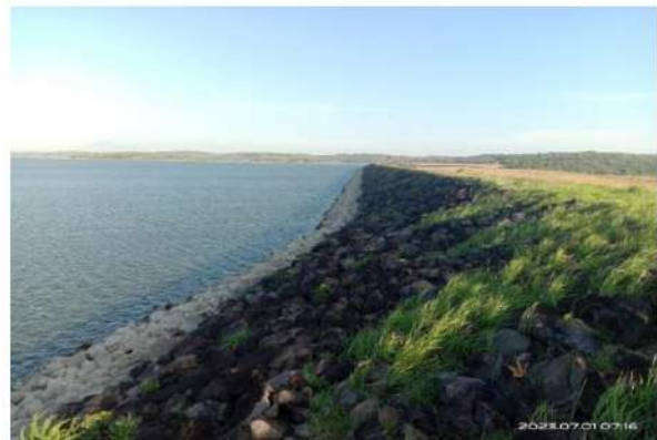
Rip rap Hulu Kiri Bendungan Kedungombo
