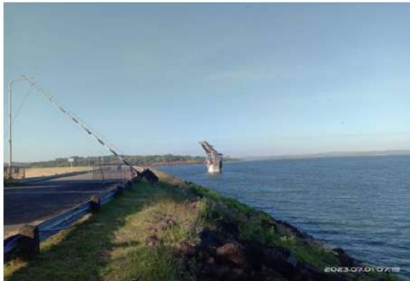
Rip rap Hulu Kanan Bendungan Kedungombo
