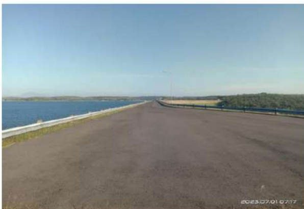
Puncak Bendungan Kedungombo
