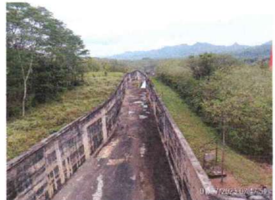
Spillway Bendungan Sutami
