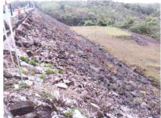
Rip rap Hilir Bendungan Lahor
