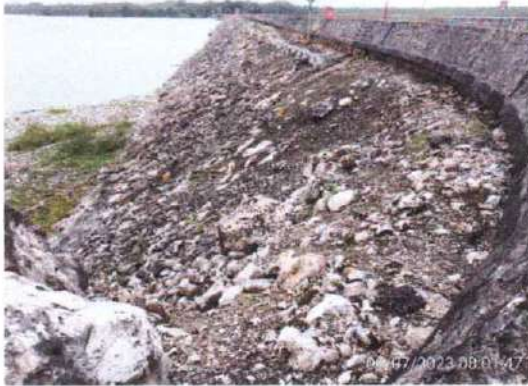
Rip rap Hulu Bendungan Sutami
