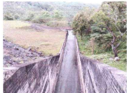
Spillway Bendungan Lahor
