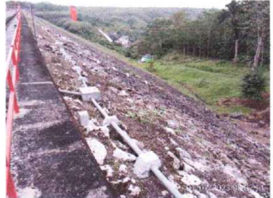
Rip rap Hilir Bendungan Sutami
