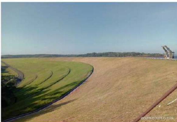
Lereng Hilir kiri Bendungan Kedungombo
