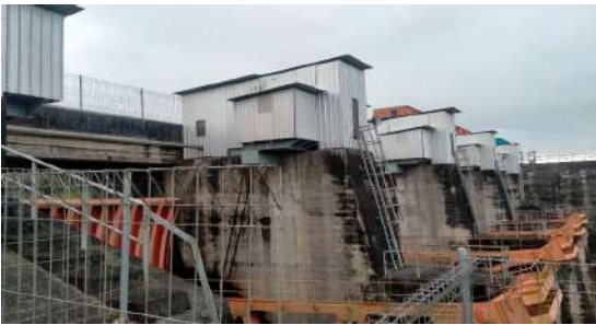
Foto Pintu Spillway
